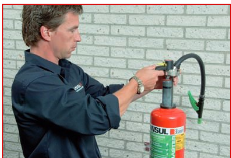
10 Brandblusser wordt weer gemonteerd
