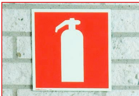
15 Is de brandblusser toegankelijk en herkenbaar aangegeven?
