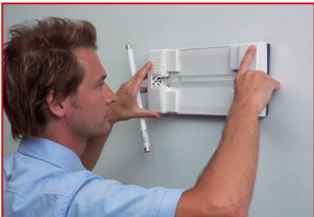
8 Armatuur in elkaar zetten en sluiten
